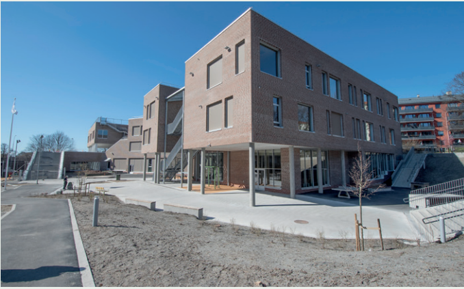
Betong og tegl er slitesterke materialer som skal bidra til en varig god skolehverdag samtidig som de gir et vink til industrifortiden ved elva.
