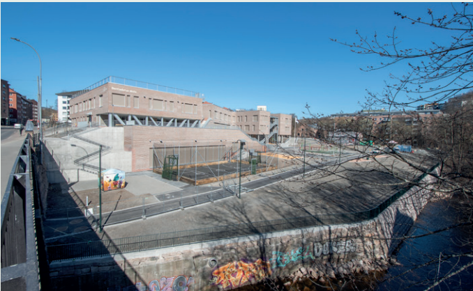
Mellom skogen og elva er det etablert ny elvepark og gangvei.
