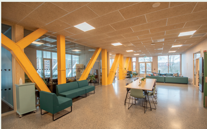
Ståldragerne som holder taket på flerbrukshallen oppe, er gjort godt synlige i den såkalte ungdomsarenaen.
