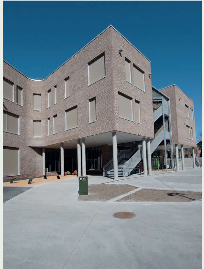
Håndverket får skinne i nye Bentsebrua skole.
